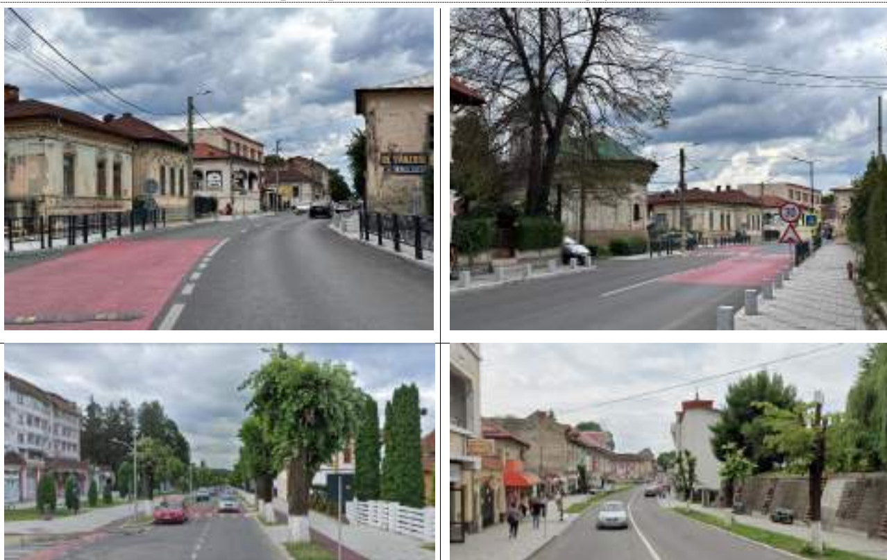
Figura 122. Amenajarea și perceperea spațiului privat în continuarea spațiului public reprezentat de drumul principal din localitatea Curtea de Argeș
